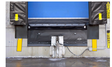
Sello debajo del nivelador PitMaster.
